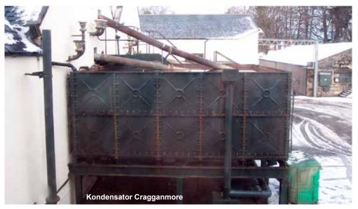
große mit Wasser durchströmte Holzbottiche (Worm Tubs), in denen sich eine kupferne Spirale für die Kondensation der Alkoholdämpfe befand. Der Wirkungsgrad dieser Kühlart ist begrenzt. Noch heute sieht man Worm Tubs bei Mortlach, Glen Elgin, Talisker oder Dalwhinnie.
